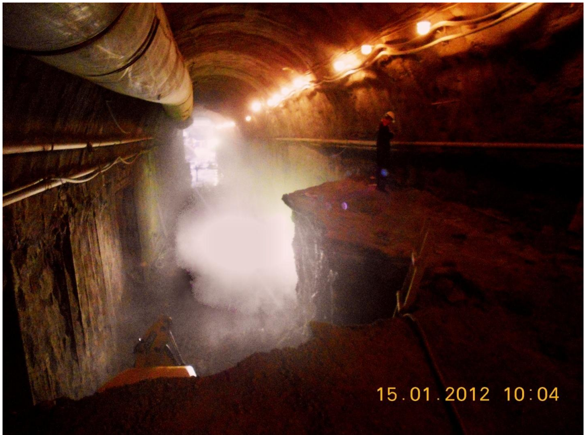
Рисунок 3.44. – Разработка уступа с левой (по пикетажу) стороны, с отставанием правой (по пикетажу) части. Район второго сечения датчиков НДС
