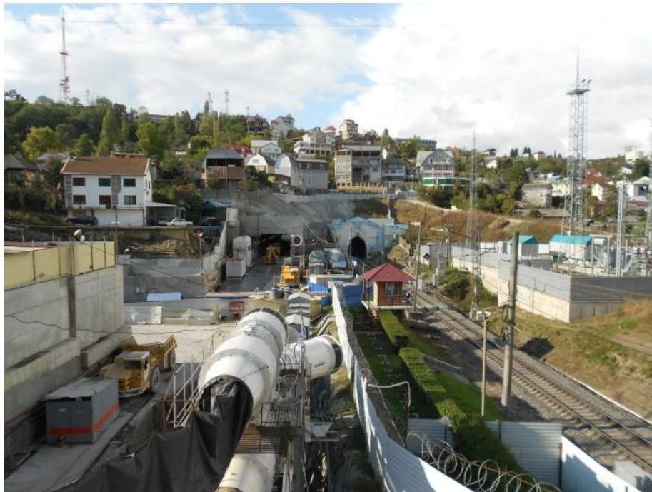
Рисунок 3.37. – Южный портал железнодорожного тоннеля № 6бис (слева) и действующего тоннеля № 6 (справа)
