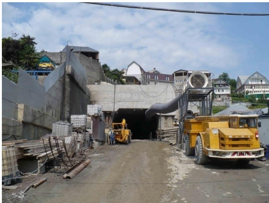
Рисунок 3.36. – Южный портал тоннеля № 6бис
