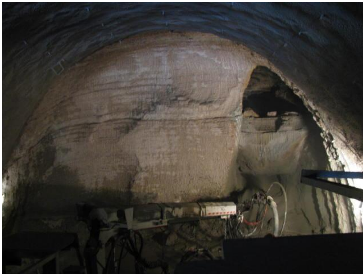
Рисунок 3.8 – Карстовая полость на ПК 148+43,30 - 148+46,00
