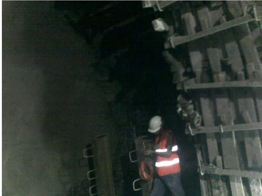
Рисунок 3.38. – Монтаж датчиков в двутавровую арку на ПК 19644+42.0
