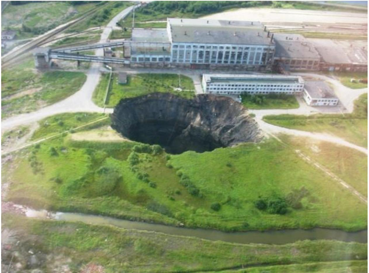
***Рис. 5.3 Провал на калийном месторождении ОАО «Уралкалий».***
