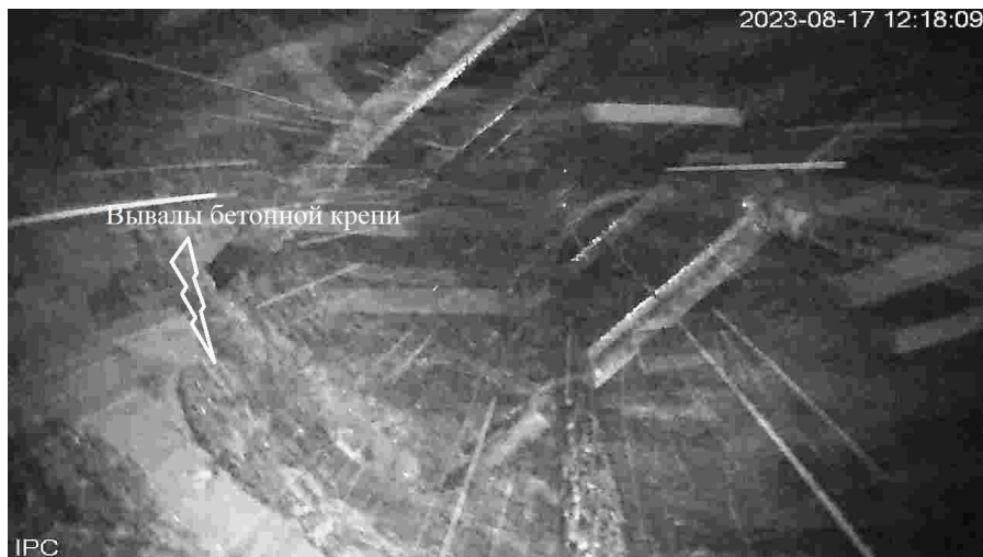
Рисунок 1 – Экспериментальные исследования в вертикальном стволе шахты «Рассвет». Вывалы в бетонной крепи в районе разбухшего аргиллита
