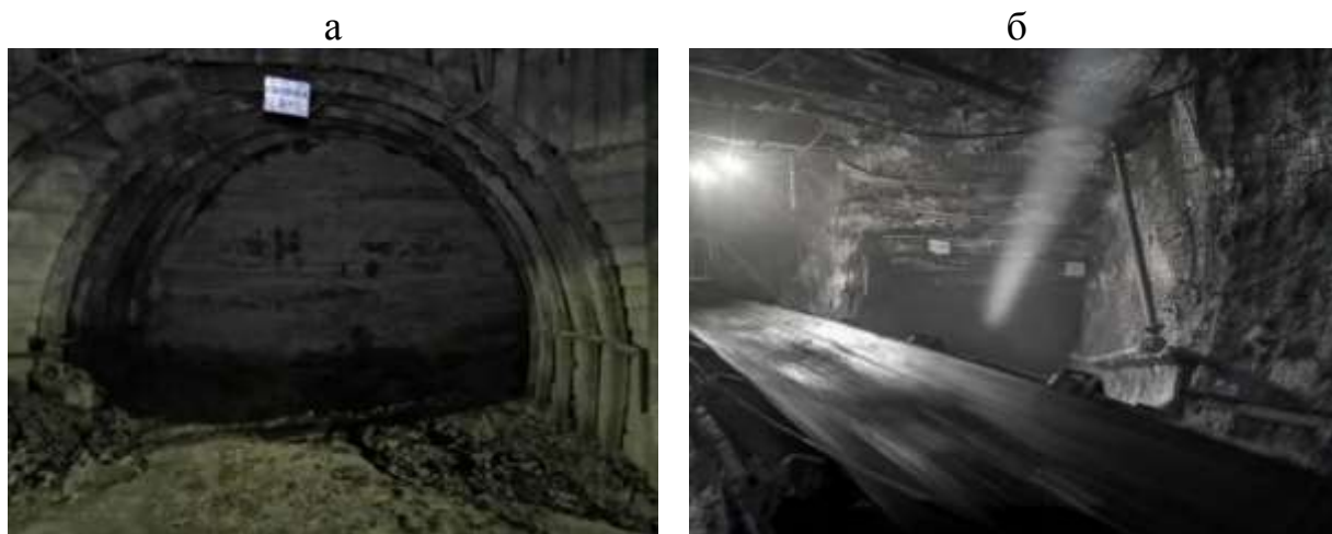
а – шахта «Полосухинская»; б – шахта «Увальная» Рисунок 4.2 – Тупики, образованные в горных выработках после возведения в них изолирующих перемычек
