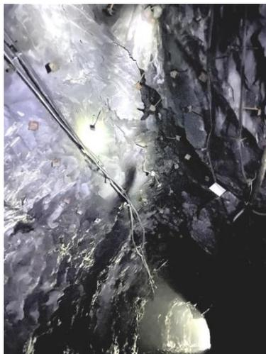
Рисунок 2.10 – Разрушенная часть кровли полевого штрека гор.-335м ЮЗРТ в зоне влияния очистных работ (разрезы 13-16)
