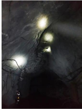
Рисунок 2.12 – Буродоставочный штрек №1 блока 12-15 ЦРТ. Вывал по контакту рудного тела с прослойкой брекчии
