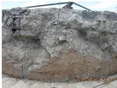
Рисунок 2 - Нарушения крепи устья ствола: а) западная стенка, б) южная стенка
