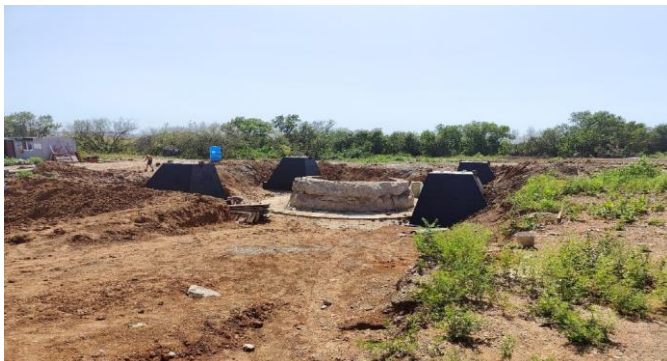
Рисунок 1 - Котлован вокруг устья вентиляционного ствола
