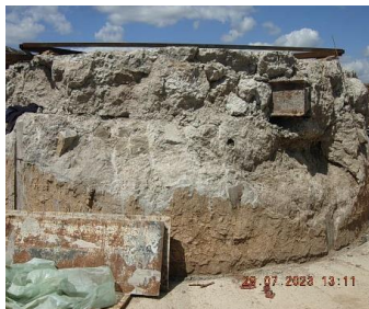
Рисунок 2 - Нарушения крепи устья ствола: а) западная стенка, б) южная стенка
