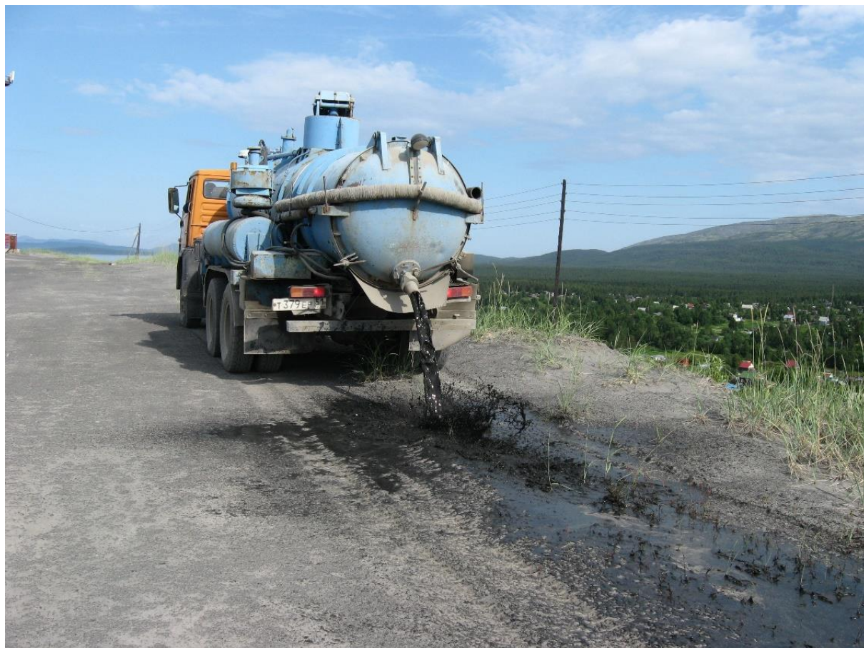
Рисунок 1.4. Закрепление дорожного полотна на хвостохранилище АНОФ-2 с помощью анионной битумной эмульсии
