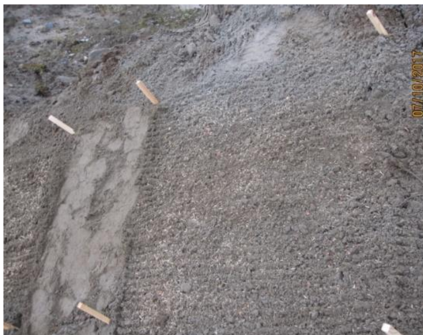
Рисунок 3.13. Прямой посев травосмеси осуществленный непосредственно на поверхность техногрунта
