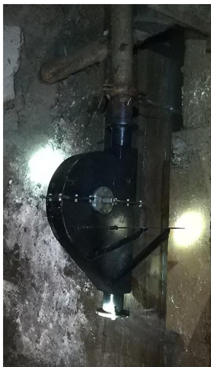
Рисунок 2.11 – Смонтированная на трубопроводе скважины №2 гидротурбина, установленная в горизонтальном положении
