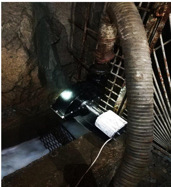
Рисунок 3.15 – Смонтированная на трубопровод скважины № 3 гидротурбина в работе
