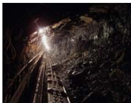
Рис. 1. В процессе отработки лавы поддерживающая способность СМК отсутствует
