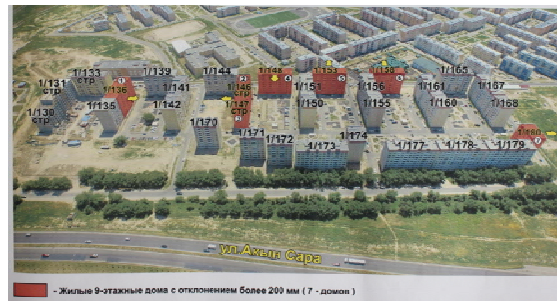
Рис. 1. Смещение отдельных жилых зданий
