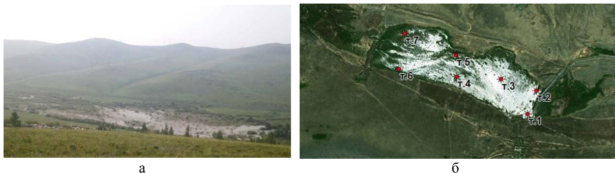
Рисунок 7 – Вид на хвостохранилище Малокулиндинского месторождения тантала со стороны обогатительной фабрики (а) и космоснимок с точками отбора проб (б)
