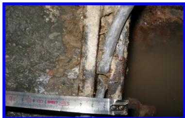
**Рис. 3. Установка чеканочного шнура на неочищенные от ржавчины тубинги**
