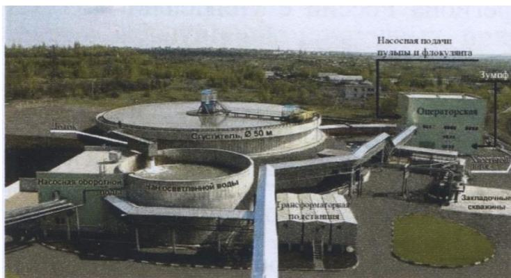
**Рис. 1. Поверхностная часть закладочного комплекса**
