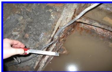
**Рис. 4. Вид на чеканочный свинцовый шнур в стыковом соединении тубинга**
