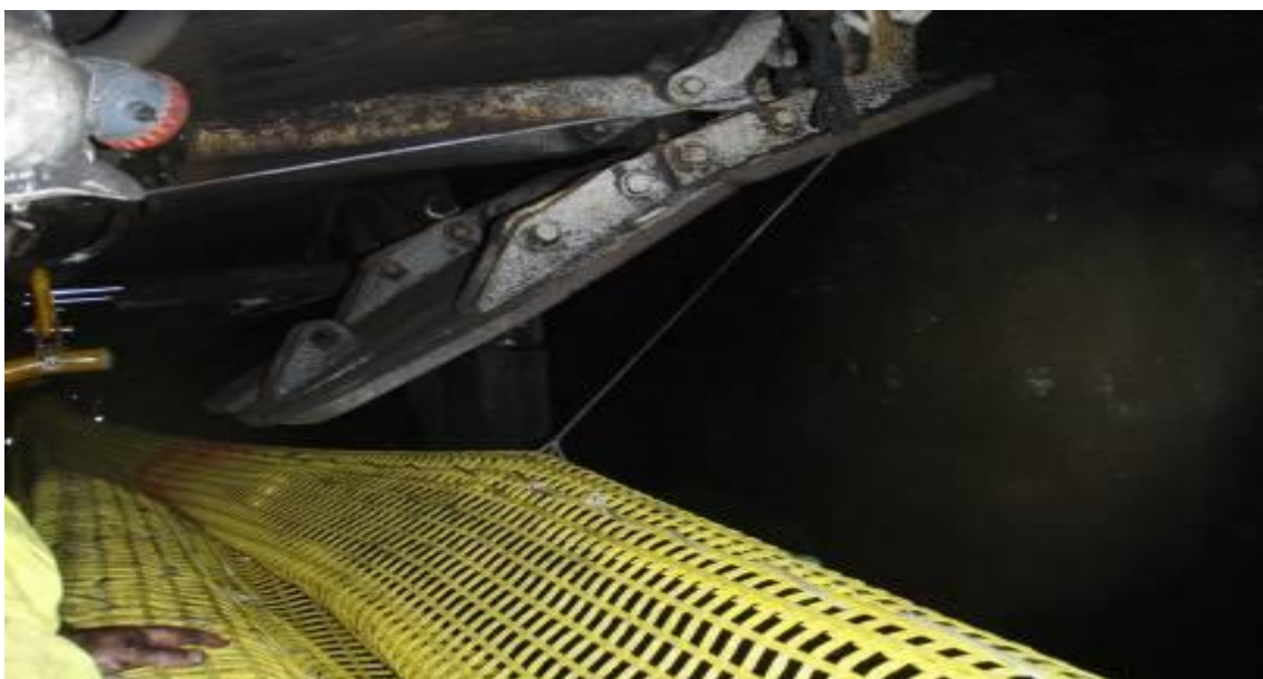
Рисунок 4.2. Вытягивания полимерной сетки ручными лебедками.
