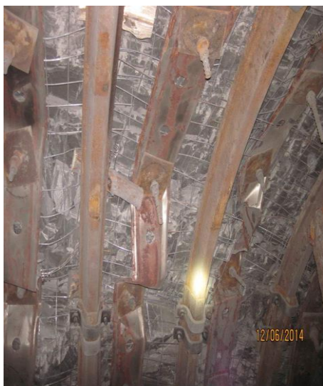
Рисунок 7 – ПК180 складывание анкерных подхватов «гармошкой»
