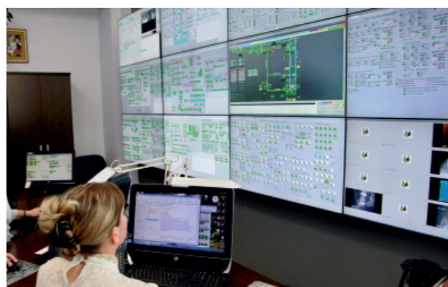
Диспетчерская по промышленной безопасности и аэрогазовому контролю
