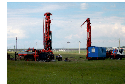
Бурение дегазационных скважин с поверхности
