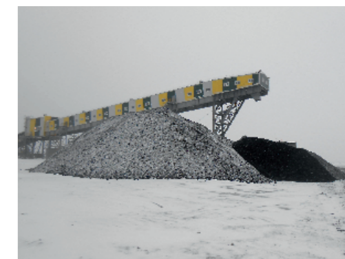
Угольный склад участка Магистральный
