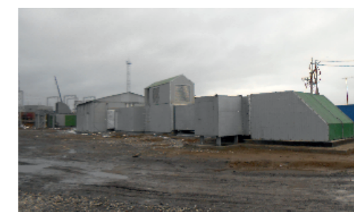
Блочно-модульная вентиляционная установка в комплекте с электрокалориферами
