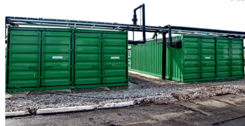
Очистные сооружения контейнерного исполнения
