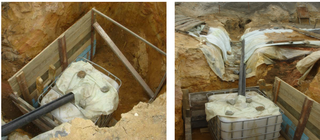
Рисунок 3.3 - Зумпф для сбора продуктивного раствора выщелачивания окомкованных хвостов обогащения
